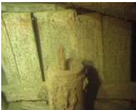
Figur 5. En av länselpumparna. Akterom ses skottet som avgränsar utrymmet under halvdäck. Foto: Anders Palm.
